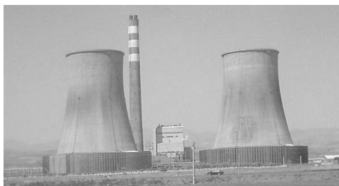
نیروگاه حرارتی بناب
