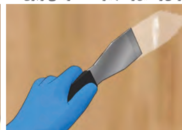
۴- صاف کردن هرگونه ترک از روی دیوار
