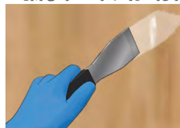
۴- صاف کردن هرگونه ترک از روی دیوار
